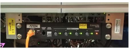
パネル 正面に Local SW (8秒押して離すと ON/OFF切替え) 背面に 100V コンセント があります
