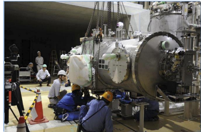
超伝導主加速器の据え付け(2012年10月)
